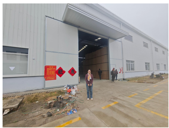
工程师现场踏勘照片
