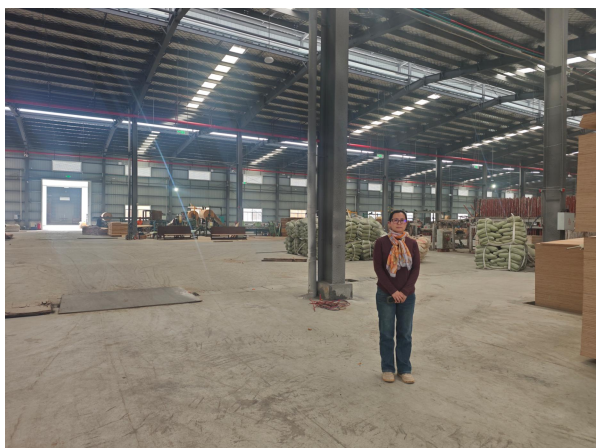
项目车间内部现状及工程师现场踏勘照片
