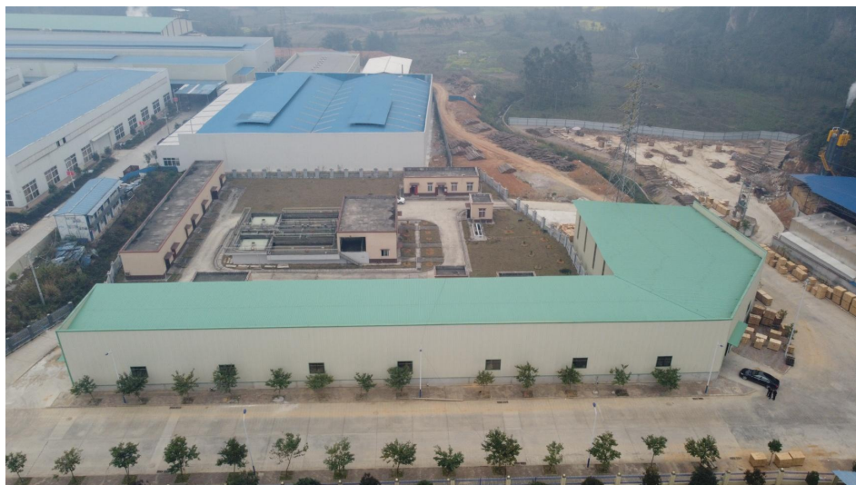
项目厂房现状
